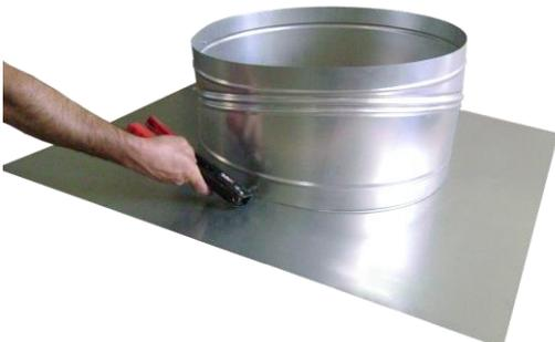
Fixar o anel de inclinação nº 1 ( montado, fixado e vedado com o anel nº 2 ) na base, com parafusos ou rebites, num total de 8 pontos equidistantes.
